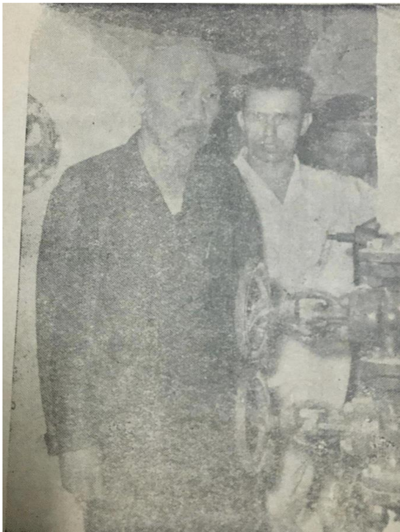
Hồ Chủ tịch kiểm tra công trường thi công nhà máy nhiệt điện Lào Cai ngày 24/9/1958.
