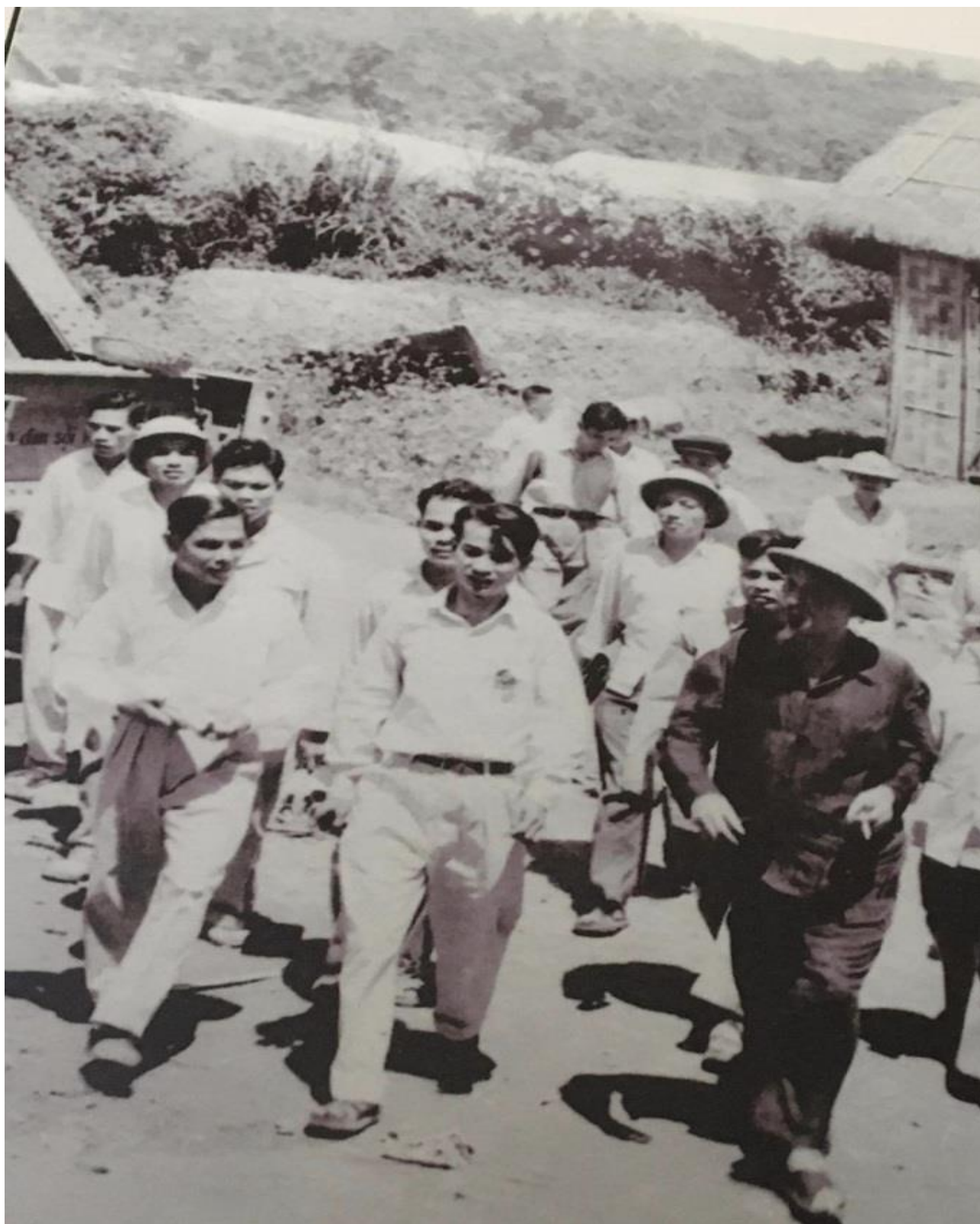
Ngày 24/9/1958, Hồ Chủ Tịch và phái đoàn Trung ương thăm công trình thi công nhà máy nhiệt điện Lào Cai lớn nhất vùng Tây Bắc do Liên Xô giúp xây dựng, phục vụ công nghiệp khai thác quặng a pa tít và điện dân sinh của tỉnh Lào Cai.
