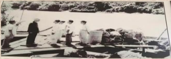
Bác Hồ thăm công nhân thi công cầu đường sắt Làng Giàng năm 1958. (ảnh tư liệu)
