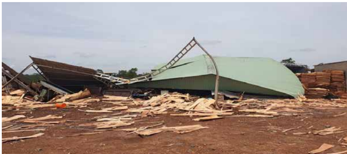
Hình 6. Mưa và lốc xoáy làm sập công trình dân sinh tại ấp Tân Khai, xã Tân Lập, huyện Tân Biên ngày 5 – 5 – 2021 (Nguồn: Minh Dương)
